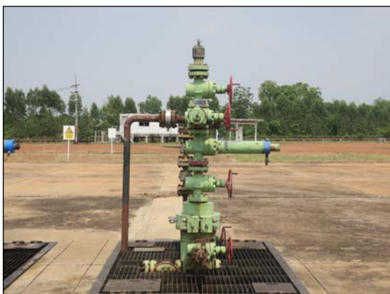
ชุดวาล์วหัวบ่อ (Christmas Tree) และบ่อเก็บน้ำบริเวณหัวบ่อ (Well Cellar Pit)
